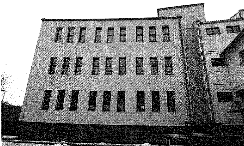
Termomodernizacja budynku głównego
