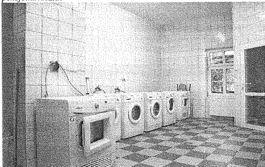
Modernizacja DPS- przebudowa garażu na pralnię
